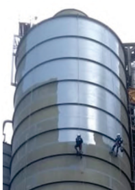
Pintura de Tanque com Alpinismo Industrial
