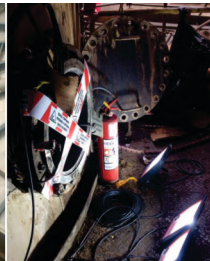
Sinalização de espaço confinado
