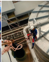
Troca de instrumento de medição com utilização de técnicas de acesso por corda
