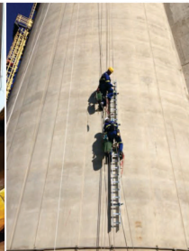
Instalação de Leito de cabos Chaminé Engie
